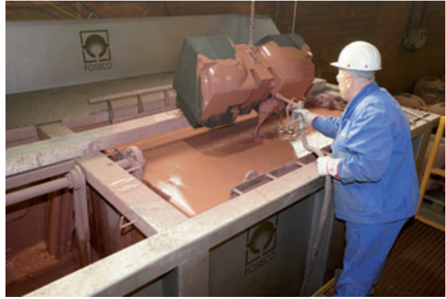
Bild 5: Die Dichtmesstechnik der ICU kann direkt in das Tauchbecken integriert werden.
